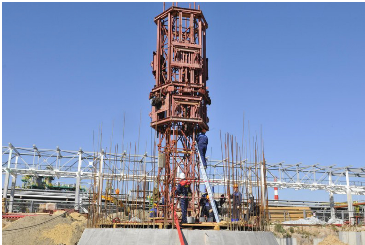
Рис. 2.44. На шахтном подъемнике (решетчатой конструкции) установлена подъемная головка, к которой будет прикреплена рабочая площадка с внешней опалубкой.
