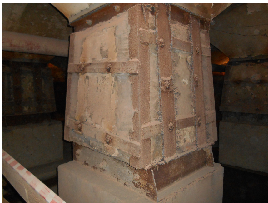
Рис. 3.33. Стальная обойма кирпичной колонны в подвале Александровского дворца. Автор фото Ю. И. Тилинин, 2020 г.
