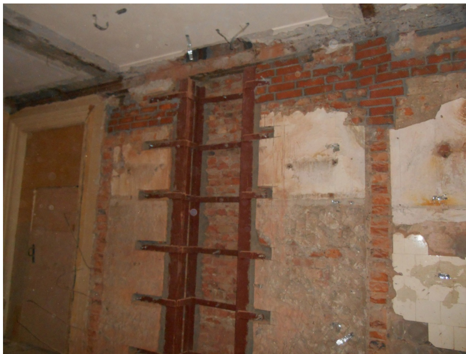
Рис. 3.37. Усиление кирпичных стен стальными накладками. Капитальный ремонт стен Александровского дворца в г. Пушкине. Автор фото Ю. И. Тилинин, 2020 г.
