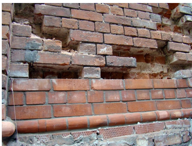
Рис. 3.28. Удаление заменяемых кирпичей при вычинке кирпичной кладки. Фото с сайта https://elite-k.ru/problemu-kladki/vychinka-kirpicha.html
