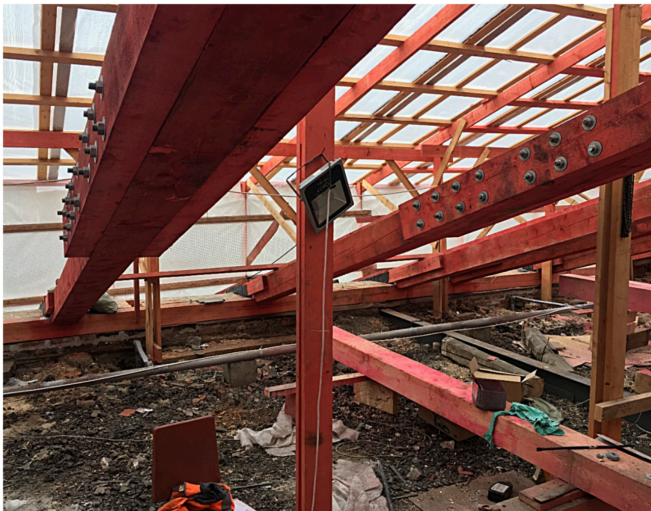
Рис. 4.9. Восстановление деревянных несущих элементов чердачной крыши с использованием традиционных накладок, соединяемых на стальных шпильках. Автор фото Д. А. Животов, 2019 г.
