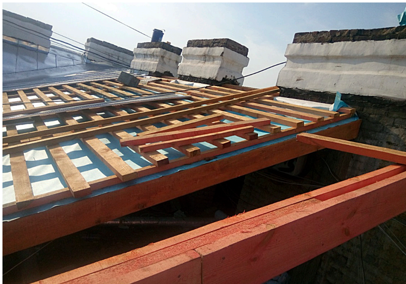
Рис. 4.16. Новая стропильная система, выполненная в процессе ремонта крыши исторического здания. Автор фото Д. А. Животов, 2019 г.
