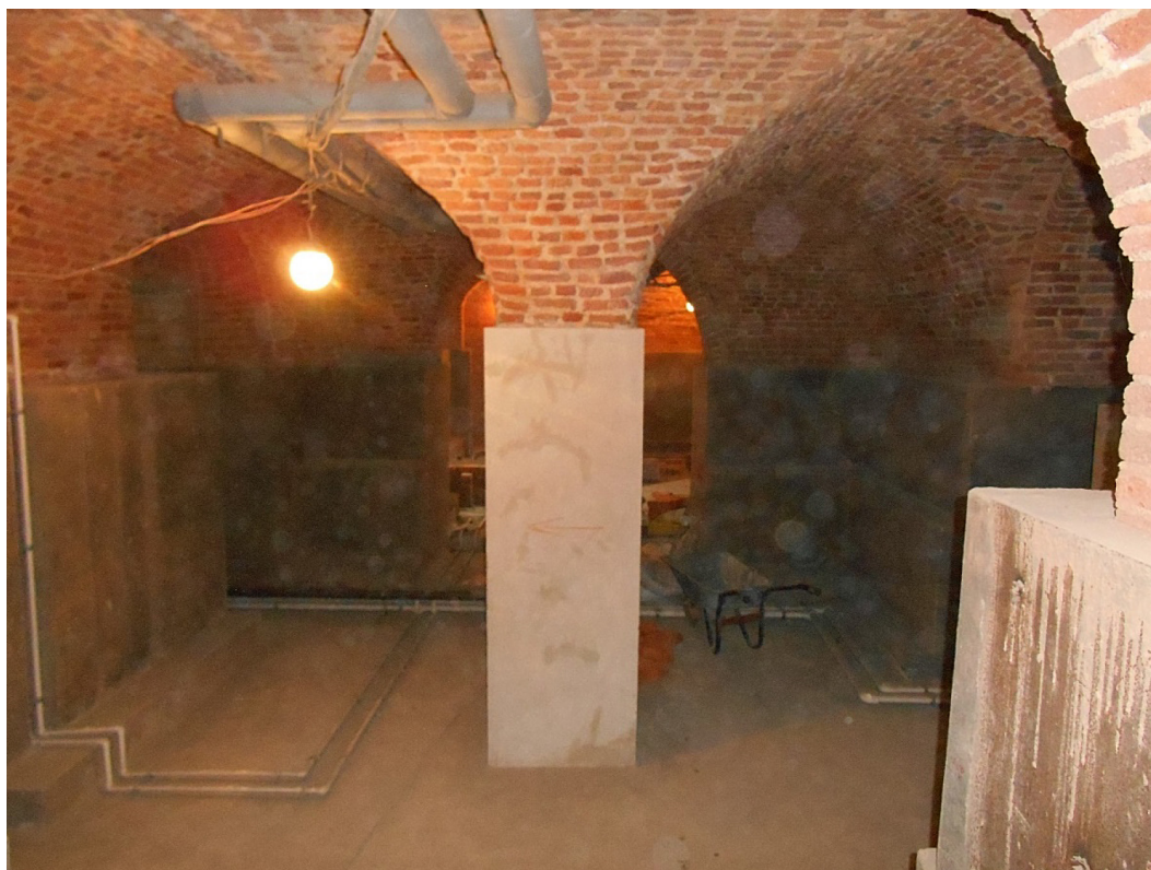
Рис. 3.35. Железобетонные обоймы кирпичных колонн в подвале Александровского дворца в г. Пушкине. Автор фото Ю. И. Тилинин, 2020 г.
