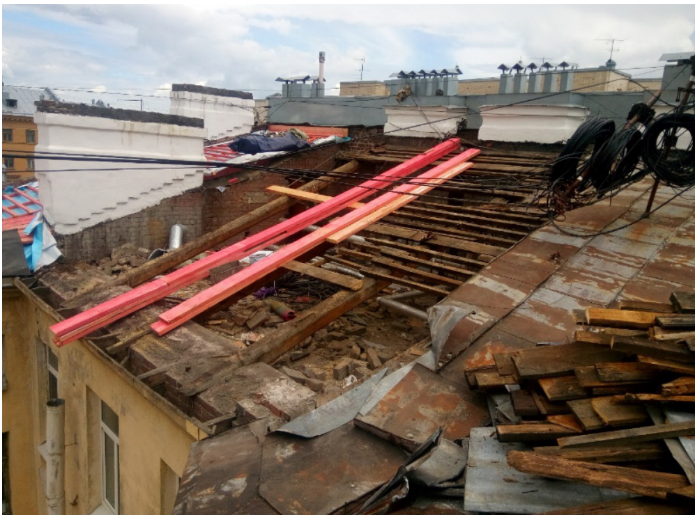
Рис. 4.8. Износ стропильной системы исторического здания в Санкт-Петербурге. Автор фото Д. А. Животов, 2021 г.
