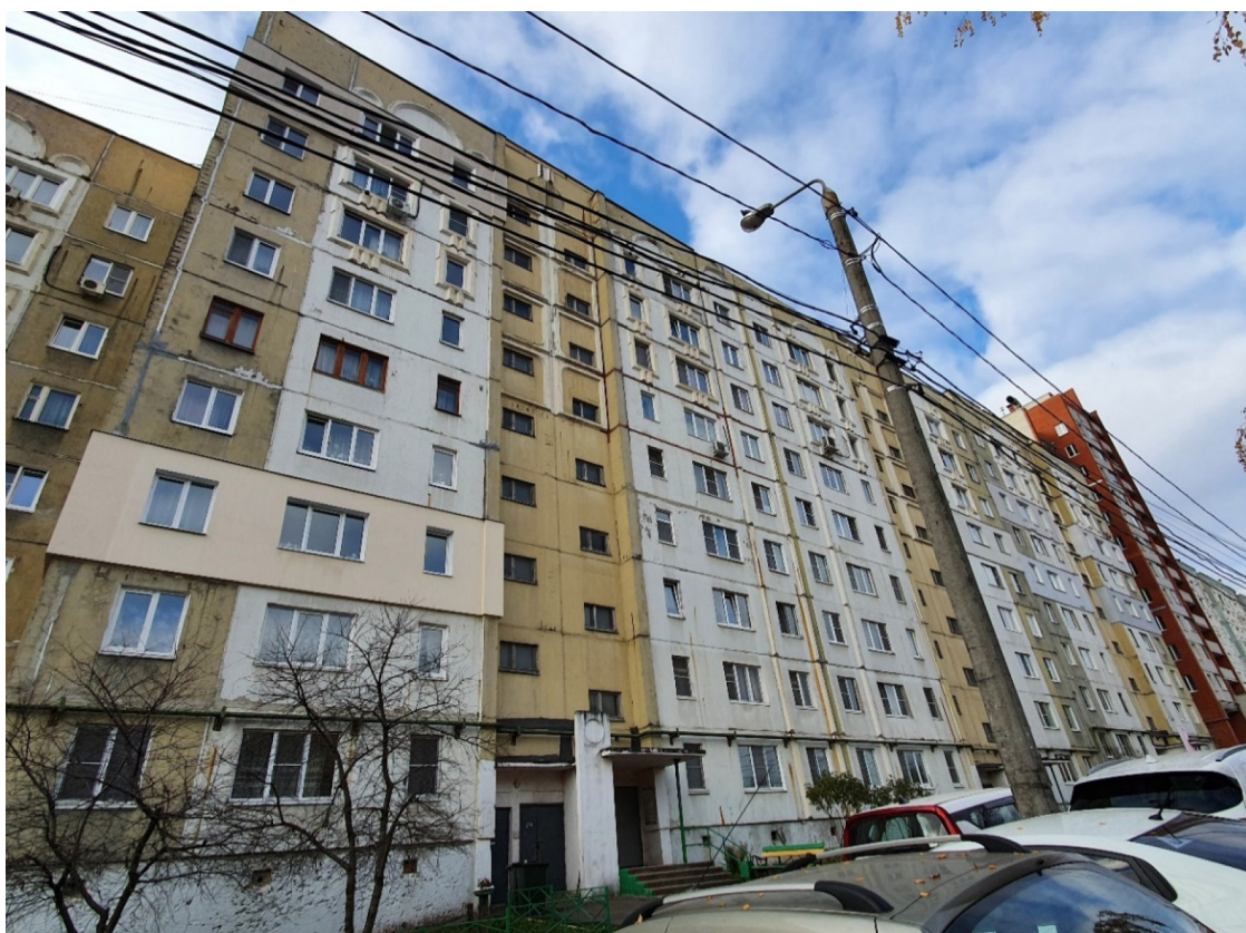
Рис. 3.4, начало. Пример утепления переохлажденных зон панельных домов с наружной стороны. Автор фото О. А. Пастух, 2020 г.
