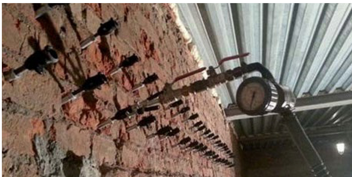
Рис. 3.21. Усиление кирпичной стены инъектированием через пакеры.
