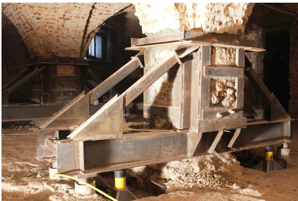
Рис. 3.44. «Вывешивание» кирпичных колонн в цокольном этаже Александровского дворца в г. Пушкине. Фото с сайта https://undergroundexpert.info/issledovaniya-i-tehnologii/tehnologii/aleksandrovskij-dvorec-reconstructia/
