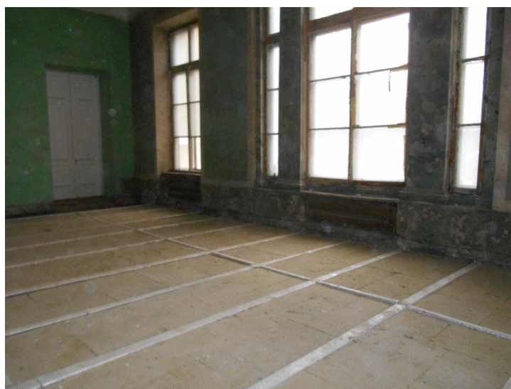
Рис. 4.1. Утепление перекрытия над подвалом. Капитальный ремонт Александровского дворца в г. Пушкине. Автор фото Ю. И. Тилинин, 2020 г.
